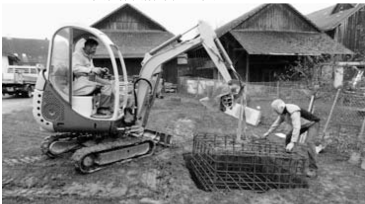
Das Fundament für den Mast
