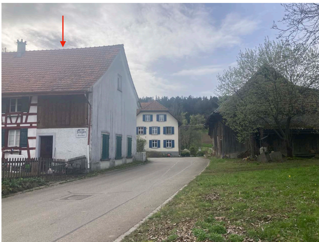
Blick von Norden.
