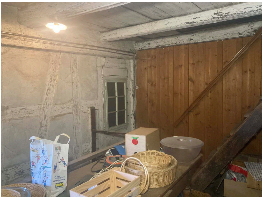
OG, Raum über der Küche mit Fachwerkwand gegen Norden und Treppe ins DG.
