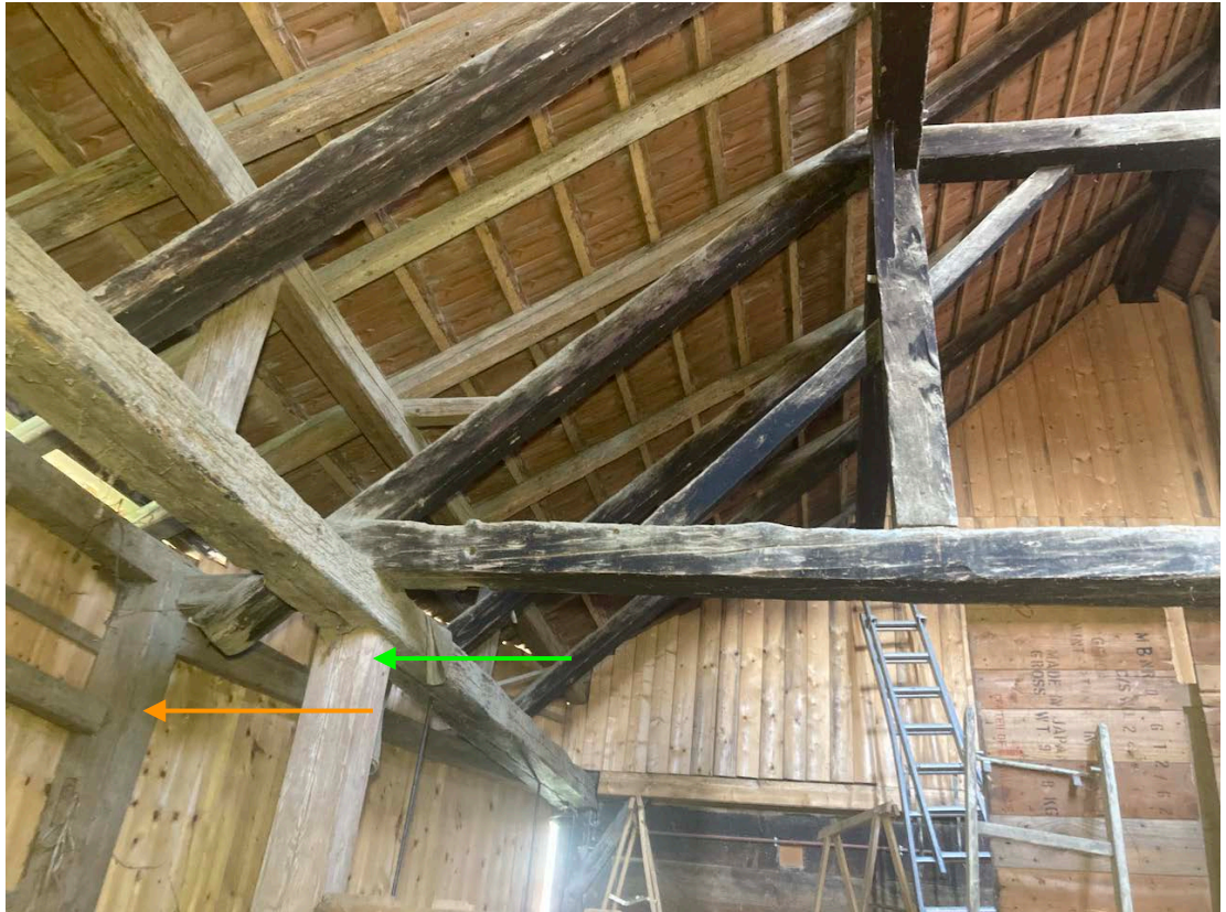
Gründer Pfeil: Bauoriginale Anordnung der Aussenwand, 17. Jh. (Ständer wurde ersetzt) Oranger Pfeil: Nachbauzeitlich gesetzte Aussenwand, um 1900.
