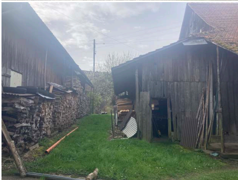
Blick Ri S, re östl. Anbau.
