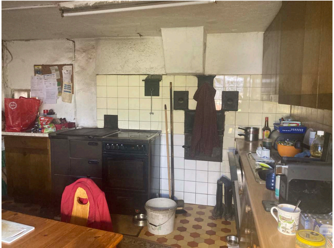
Küche mit Feuerungswand zur Stube.
