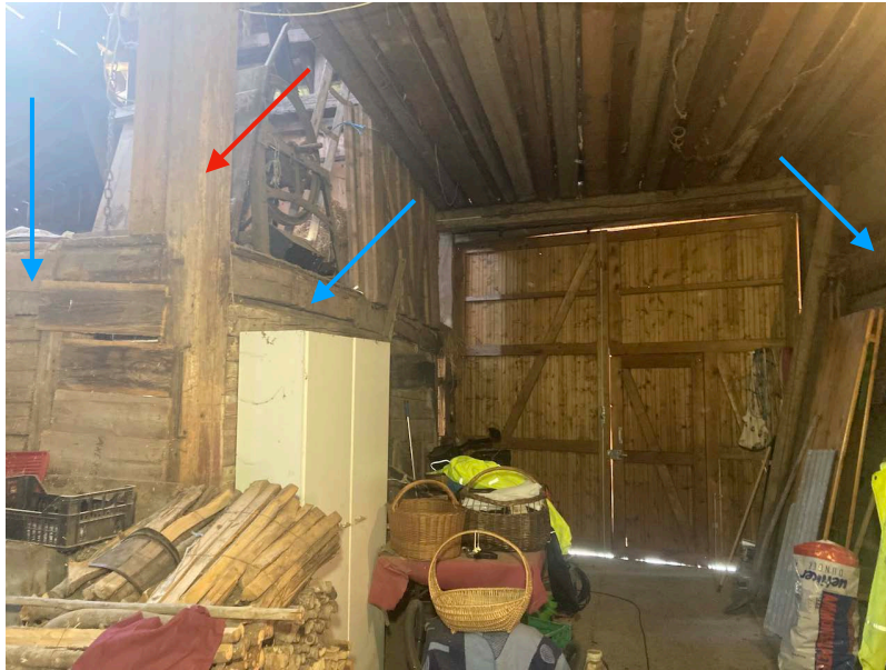
Zweigeschossiger Eckständer (roter Pfeil) und Bohlenwände (blaue Pfeile).
