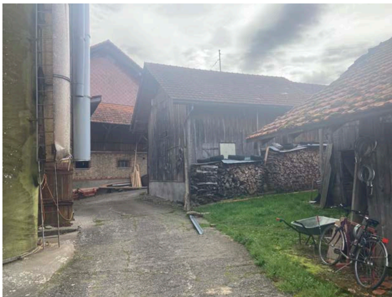
Blick Ri O, re nördl. Anbau.
