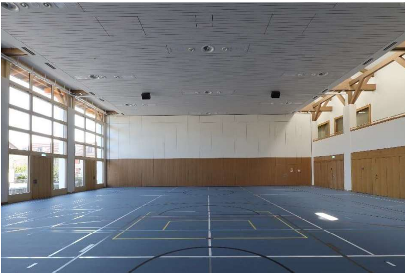
Neue mobile Trennwand in der Turnhalle und neue Turnhallendecke
