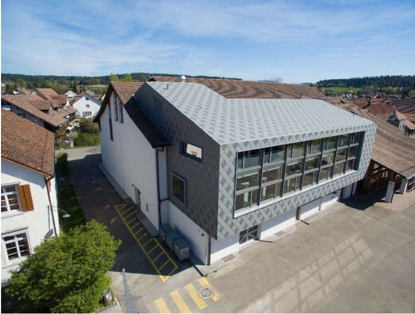
Neubau/Aufstockung Bibliothek aus der Vogelperspektive
