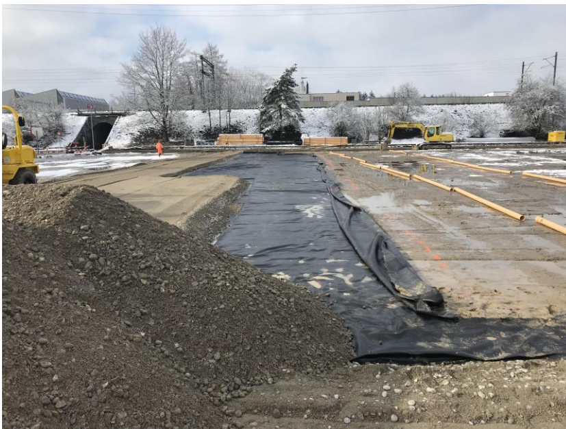
Einbau Trennvliess und Fundationskies und fortlaufender Leitungsbau
