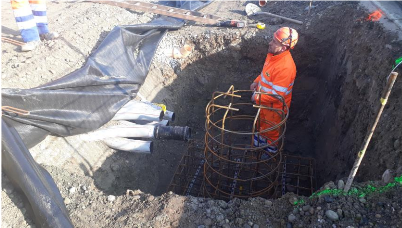
Armierung Fundament Beleuchtungskandelaber
