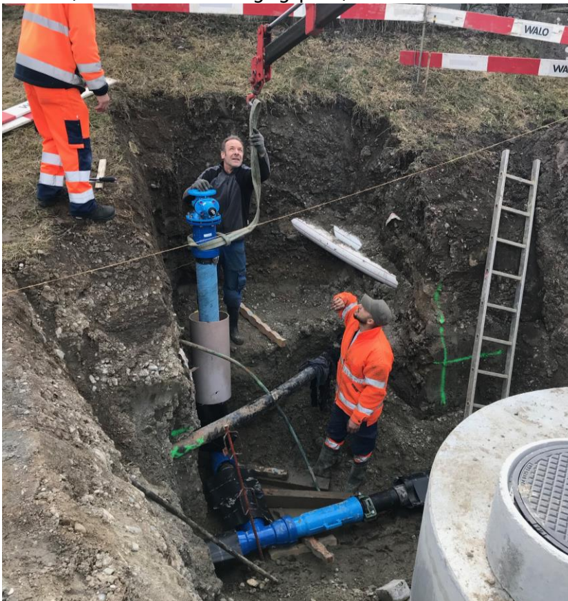
Montage Schieber auf Hauptleitung
