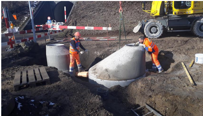
Meteorwasser-Hauptsammelschacht
