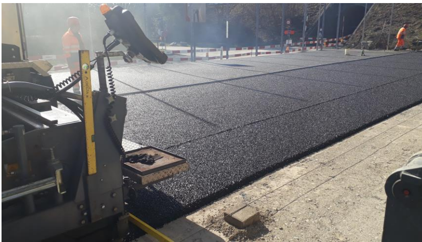
Einbau Drainasphalt
