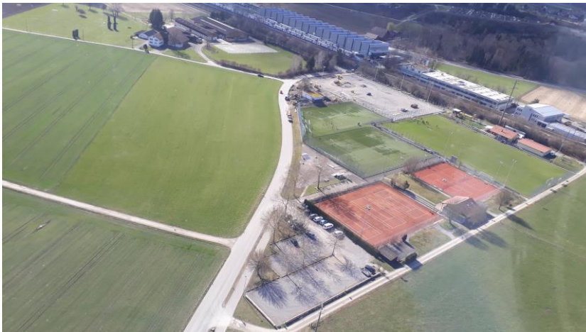
Baustelle aus der Vogelperspektive
