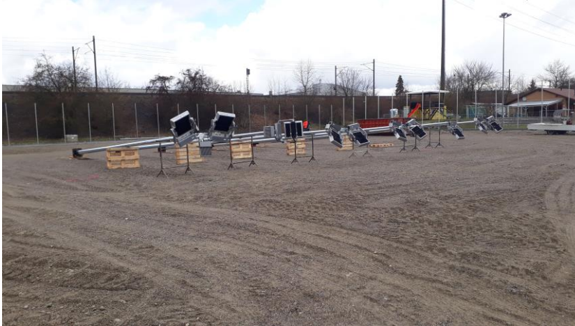
Beleuchtungskandelaber bereit für Abflug
